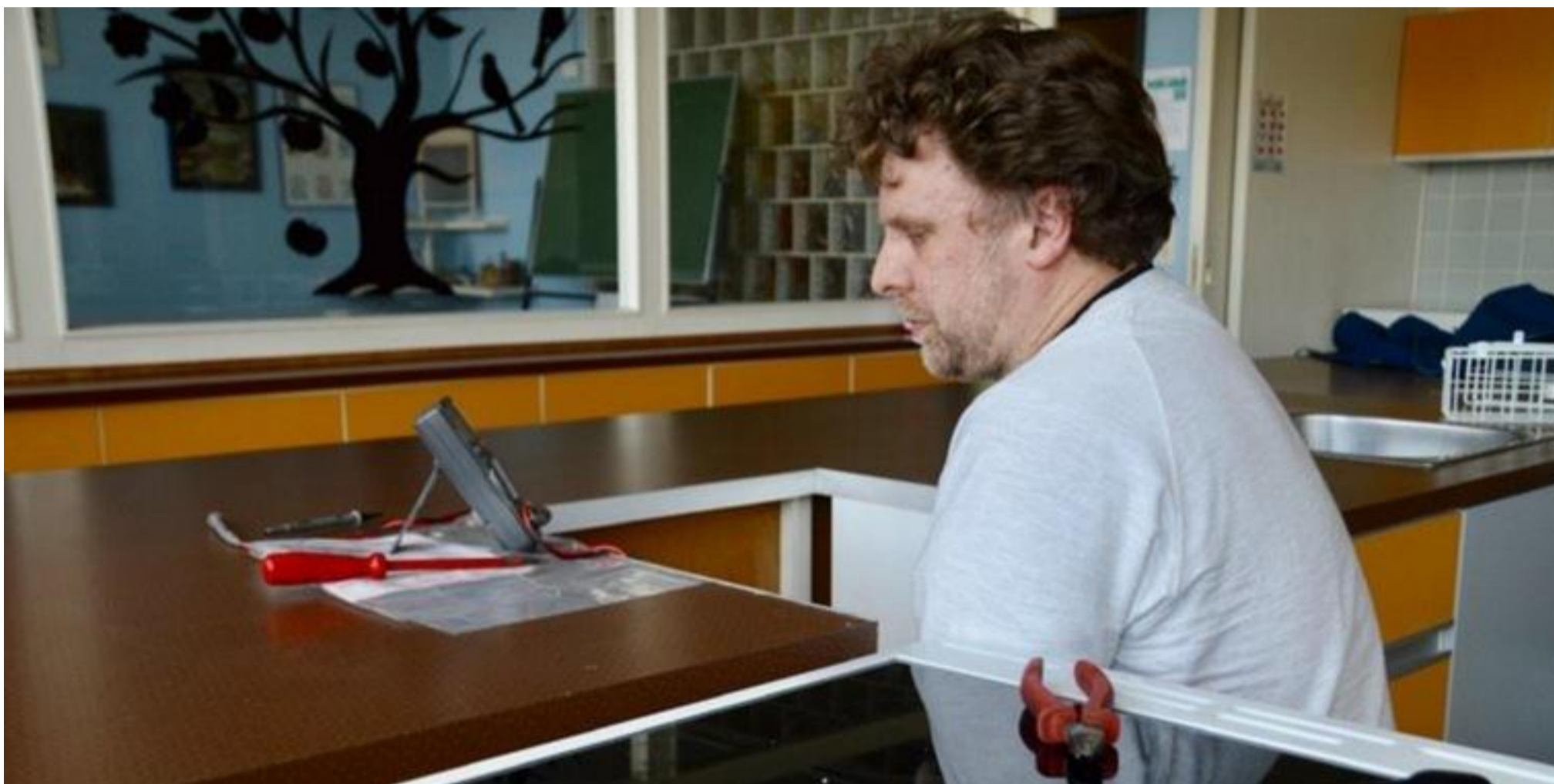
Handwerker Matthias Müller prüft den Elektronanschluss für einen der neuen Herde. Die Gemeinde richtet in den Osterferien die Lehrküche wieder so her, dass alle Einheiten genutzt werden können. Quelle: Kerstin v. Schmidt-Phiseldeck
